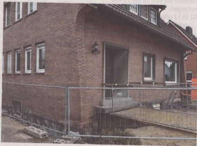
Zum ersten Mal wird in Lippamsdorf an der Straße Im Winkel ein bergbaugeschädigtes Haus gehoben. Die Arbeiten dauern noch bis Juli und kosten 280 000 Euro.
