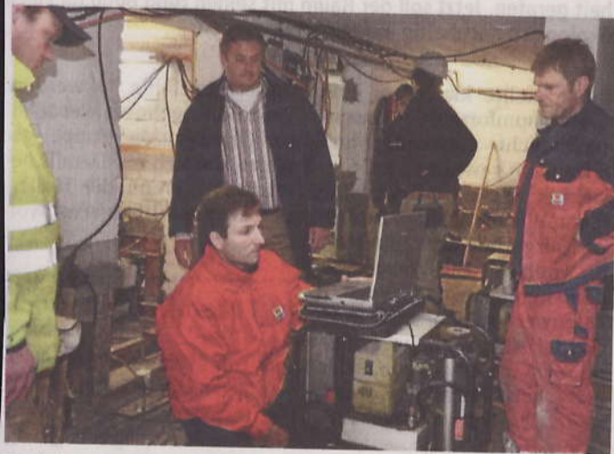
Bauleiter Thorsten Mateling überprüft gerade die Funktionsfähigkeit der Pressen. Andreas Mollinga (3.vl.), Sachverständiger für Bergschäden, beobachtet den Fortgang auf der Baustelle.
