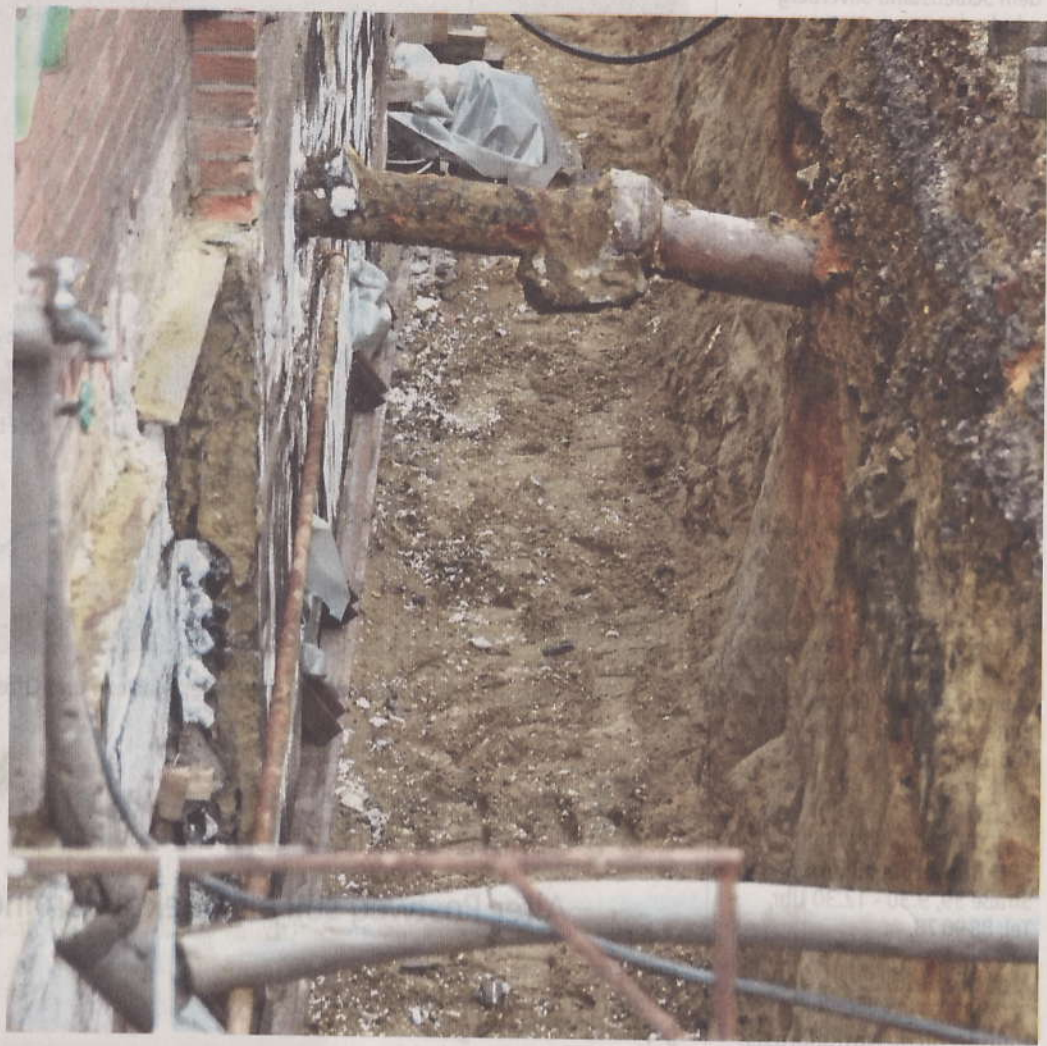
Das Wohnhaus in der Mersch ist bis zum Fundament freigelegt. 44 Pressen trennen das Haus nun vom Fundament und richten es aus. Anschließend wird das Bauwerk neu unterfüttert.
