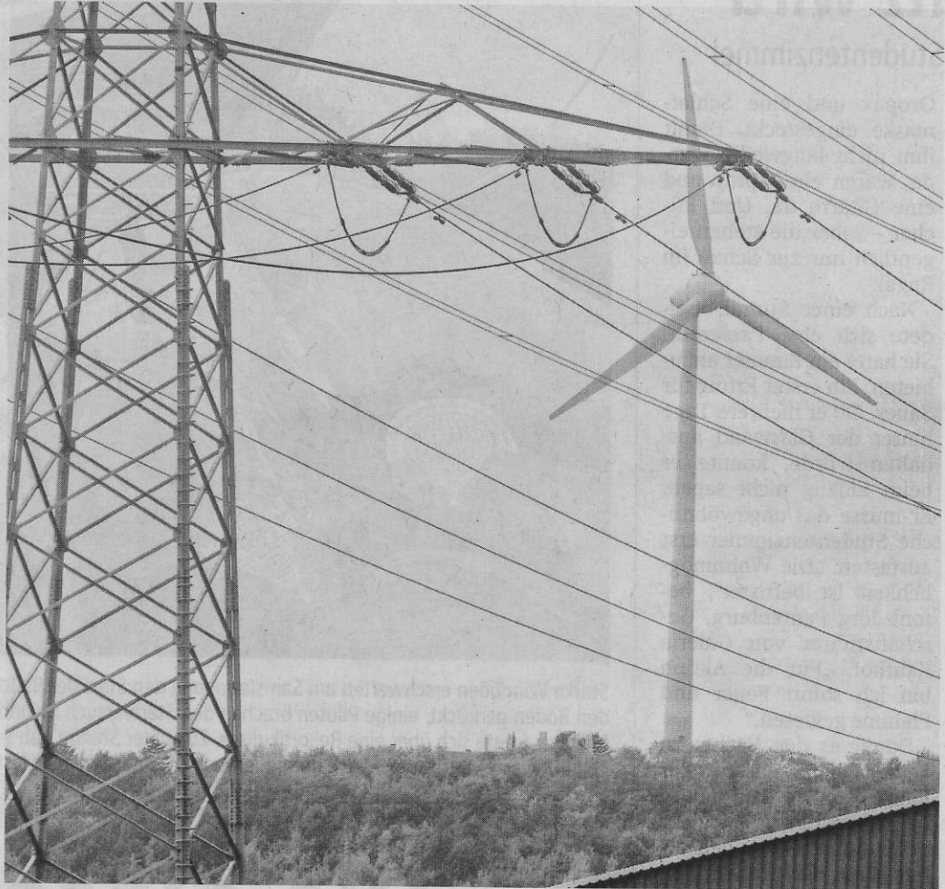
Öko-Strom von der Halde: Die Windkraftanlage auf der Halde Hoppenbruch in Herten-Süd. Vorbild für weitere Anlagen solcher Art im Ruhrgebiet?
