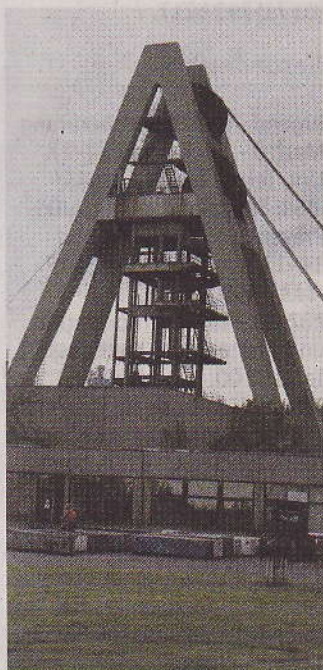
Der prägnante Zechenturm wird abgebaut.
