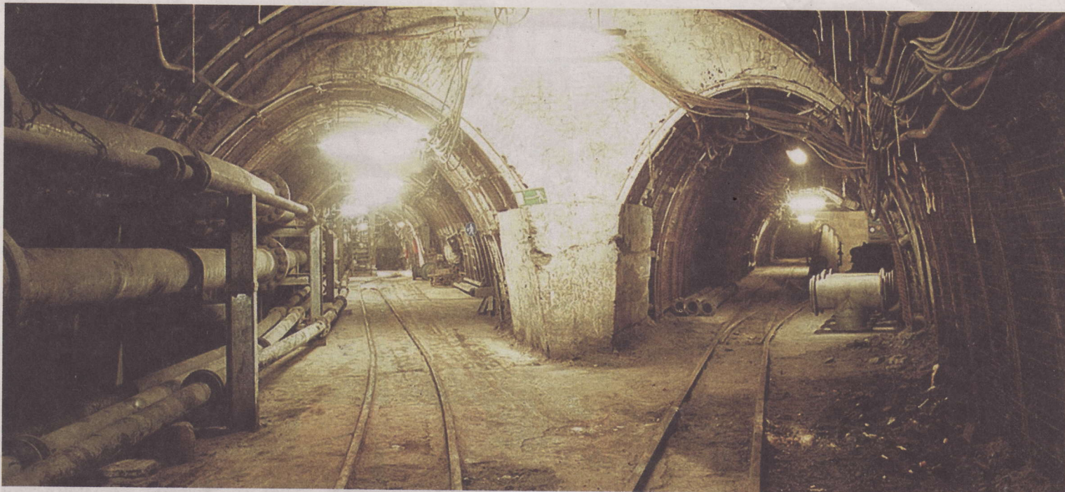
In alten Schächten des Steinkohlenbergbaus schlummern womöglich Gefahren für die Umwelt.
