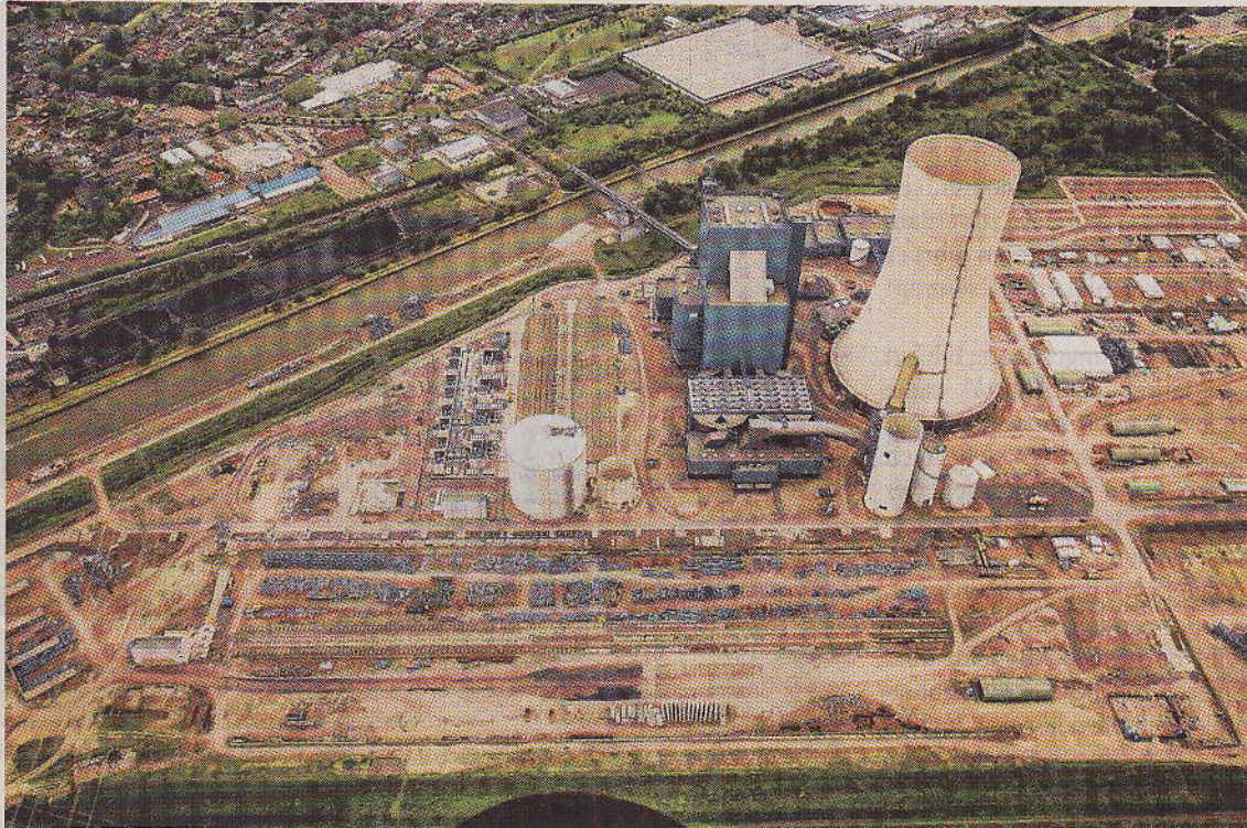
Kühlturm, Kessel- und Maschinenhaus sind nahezu fertig. Andere Teile gammeln wegen Baustopps vor sich hin. FOTO: GUTZEIT
