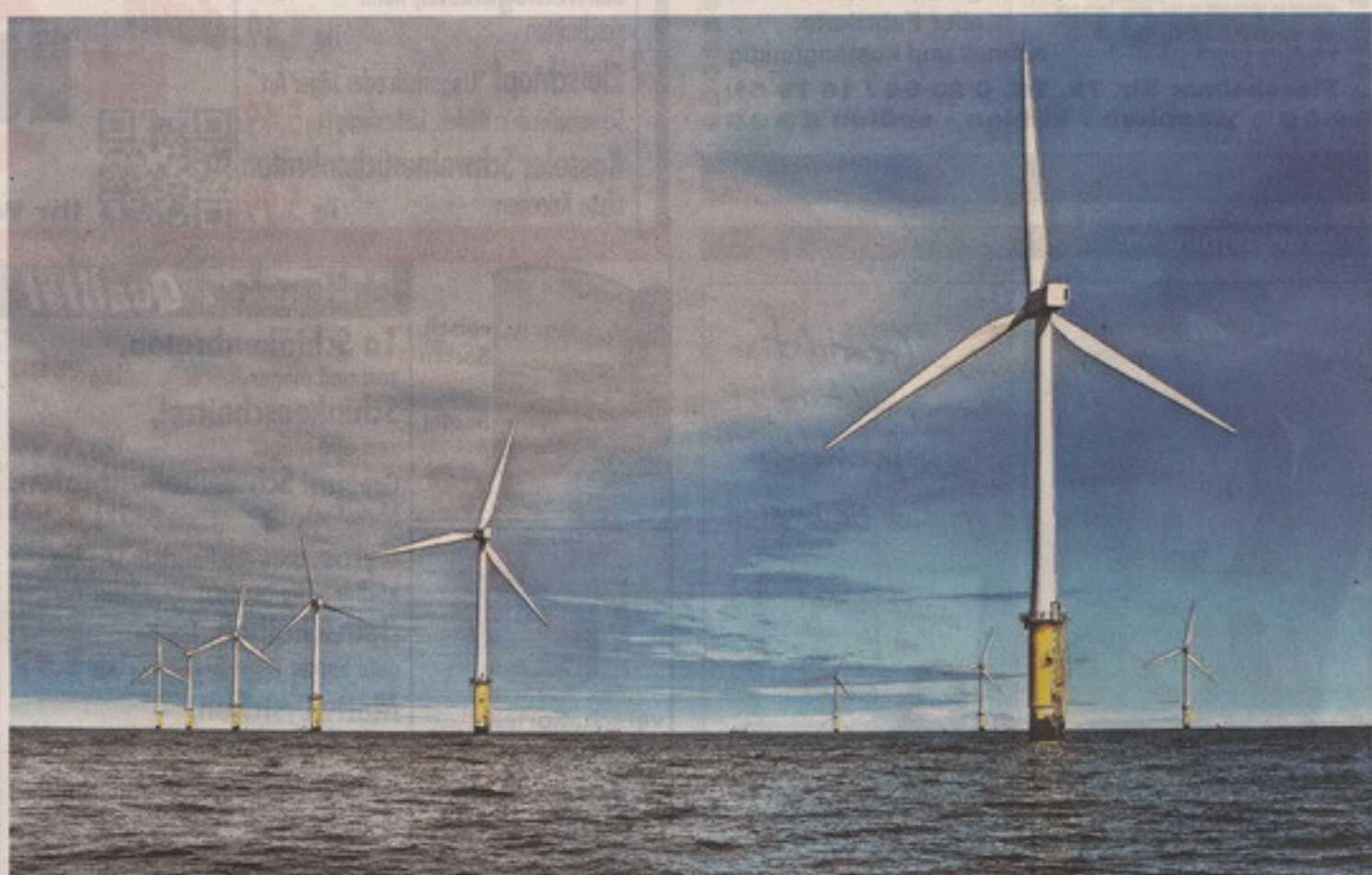
Zwangsabschaltungen von Windparks aufgrund fehlender Leitungen sollen künftig nicht mehr notwendig sein.
