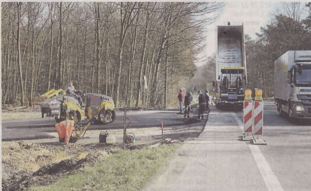
Das Bauvorhaben Windenergie (A1) an der Sythener Straße ist in vollem Gang. Die Zuwegung wurde vor Ostern asphaltiert. Doch vielleicht kommt es bald zum Baustopp. RN-FOTO STEFFE
