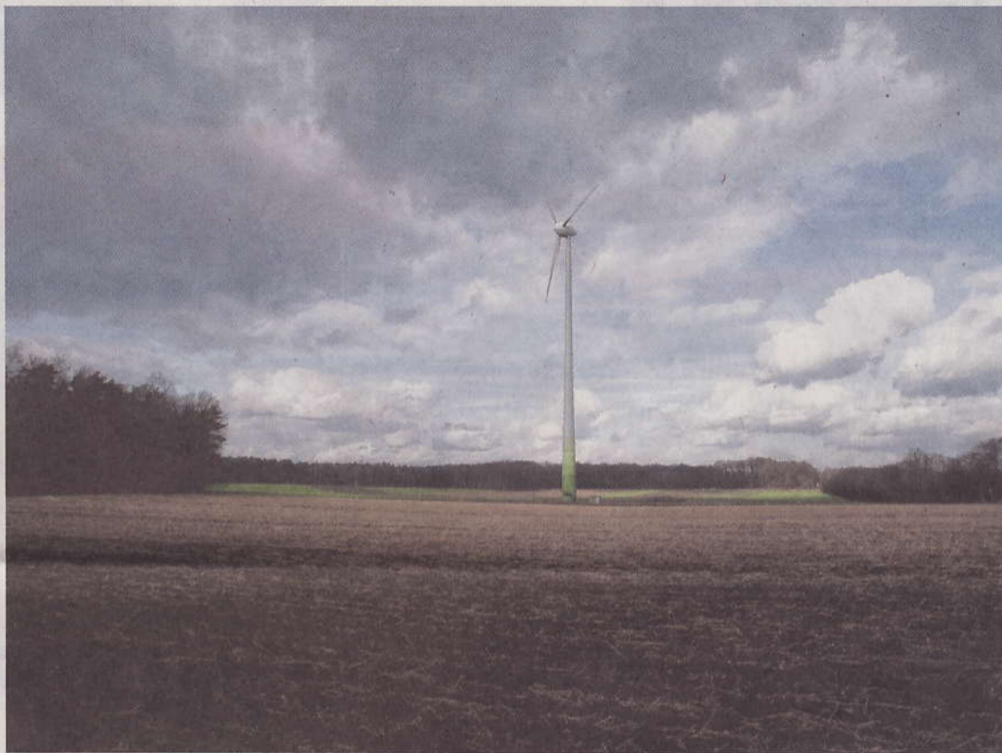
Noch steht die Windkraftanlage einsam auf dem Gelände zwischen Uphusen und Münsterstraße. Das wird sich ändern. Das Gebiet ist nun Windvorrangzone.
